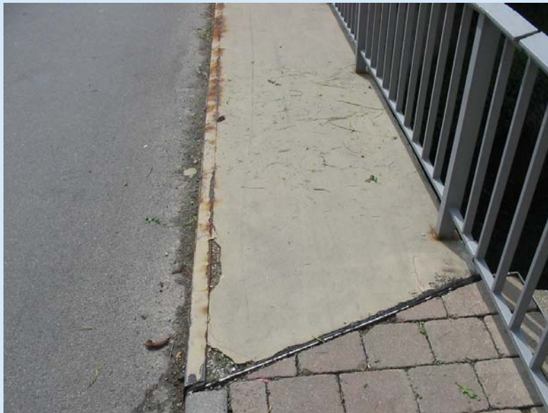
Erhaltungszustand vor Instandsetzung
