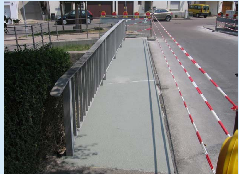
Erhaltungszustand nach der Instandsetzung
