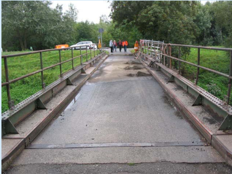
Erhaltungszustand vor Instandsetzung
