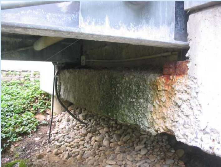
Chloridbelastetes Widerlager bei der Brücke am Kindergarten
