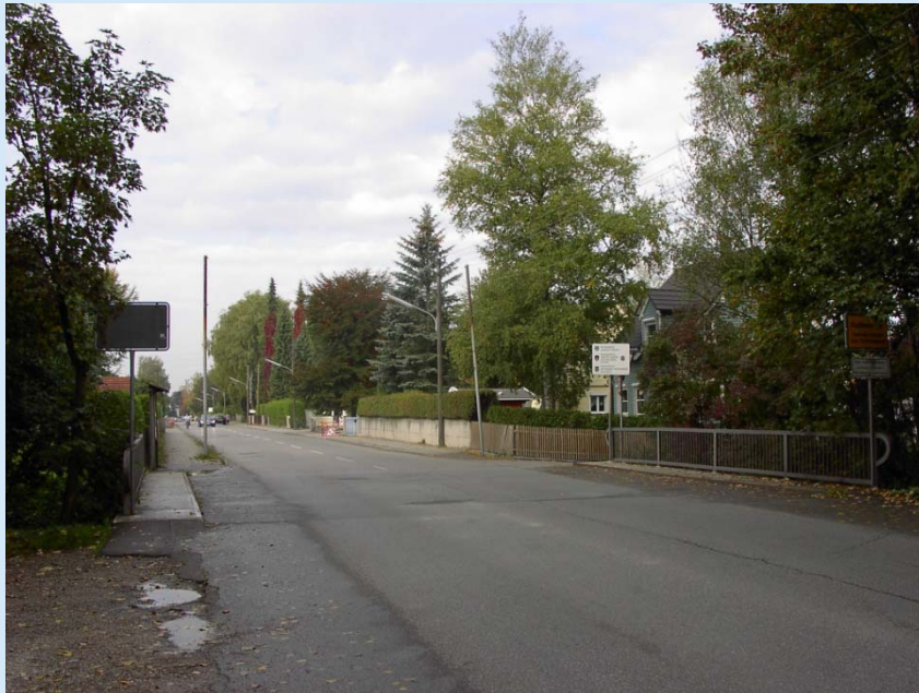
Erhaltungszustand vor Instandsetzung
