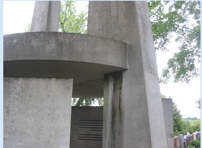
Undichte Fugen am Becken des Glockenturms
