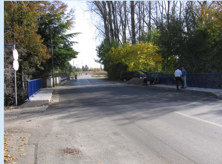
Erhaltungszustand nach der Instandsetzung
