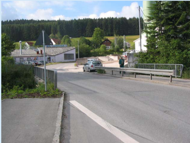
Erhaltungszustand vor Instandsetzung
