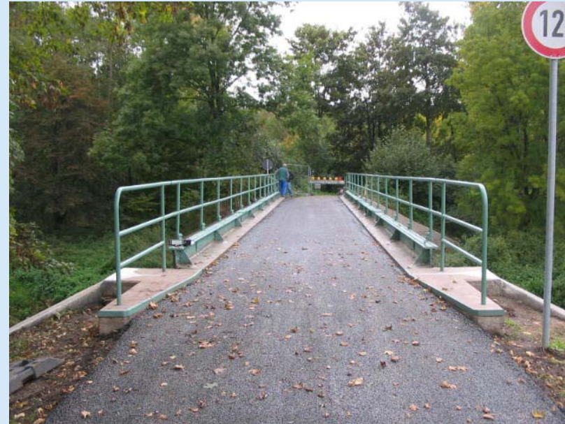
Erhaltungszustand nach Instandsetzung
