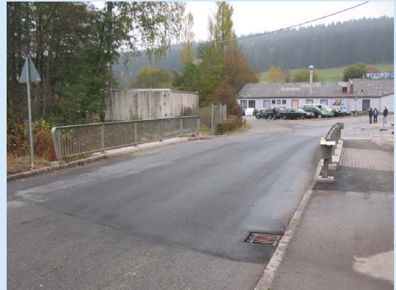
Erhaltungszustand nach der Instandsetzung
