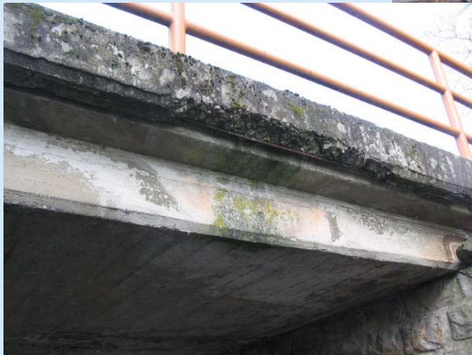
Erhaltungszustand vor Instandsetzung
